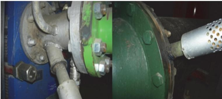
Рис. 2.4.3-5 Монтаж УЗ преобразователей на пластинчатом (слева) и пароводяном теплообменниках
