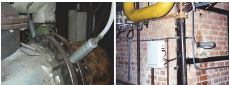
*Рис. 2.4.3-3 Излучатели ультразвука, приваренные к подогревателю ГВС и к коллектору парового котла.
